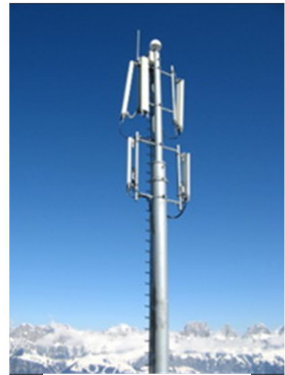
Рис. 7 Труба з антенами стандартів GSM-900 і GSM-1800
